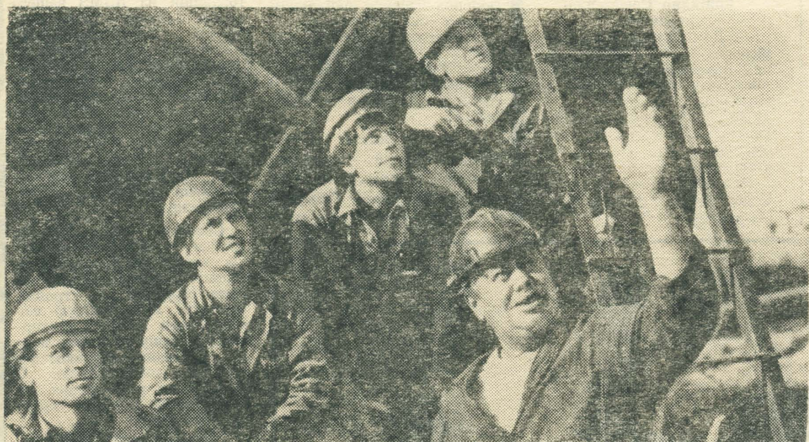
Бригада Героя Социалистического Труда В. А. Еремينا из НМУ-2 Сибметаллургомонтажа ведет монтаж изотермической емкости в корпусе 684. Фото В. Грызыхина.
