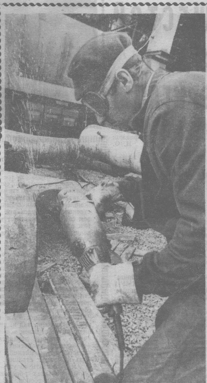
НА СНИМКЕ: монтажник Алексей Леденев из бригады И. С. Федосеева зачищает трубу высокого давления. Фото В. Грызыхина.
