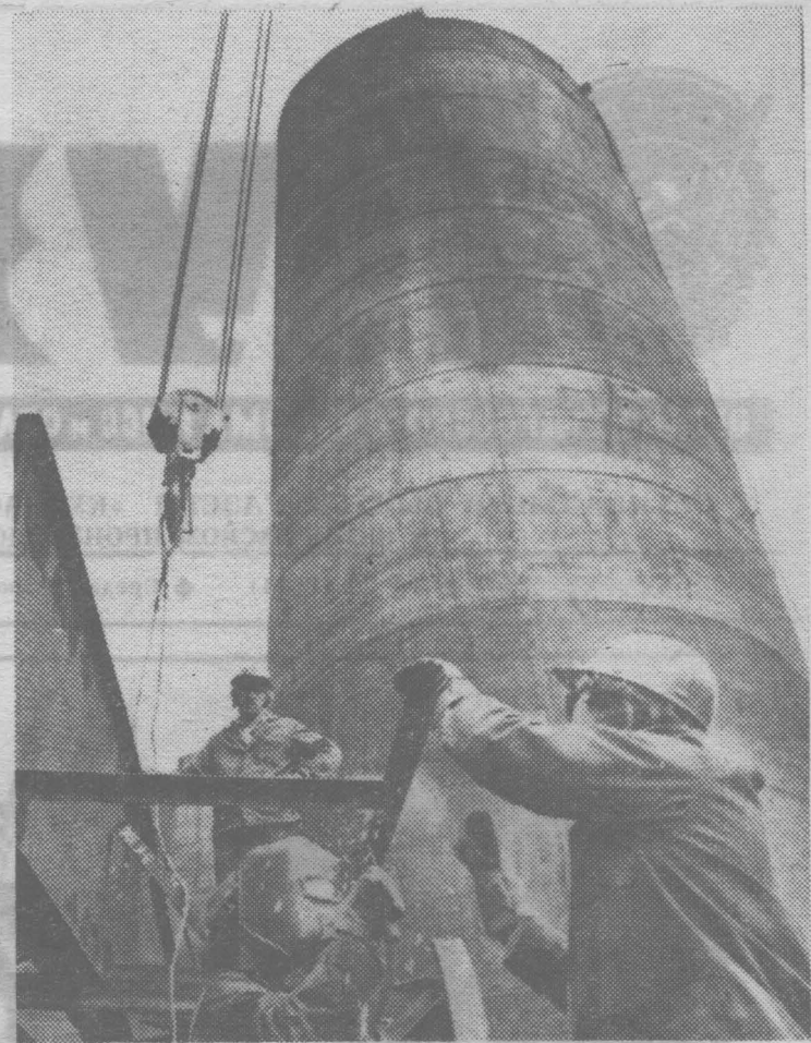
Бригада В. Ф. Дорохина (НМУ-2 СММ) на монтаже изостермической емкости.
