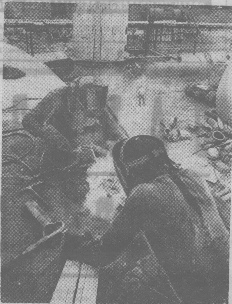
На комплексе «Аммиак-2» работают не только кузбассовцы. Сварку на абсорбере ведут рабочие пензенского завода «Химмаш» Н. Наянов и М. Убоженко. Фото В. Грозного.
