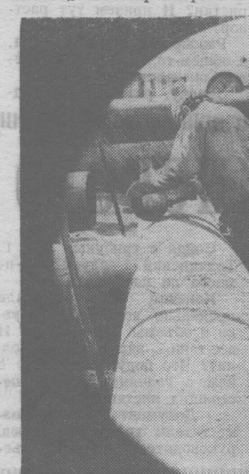
Монтажники В. Снегарьков и А. Молчанов из бригады В. Алешина — КМУ-1 Сибметаллургомонтажа — ведут зачистку стыков труб.
