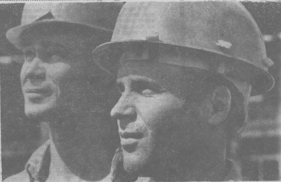
На важнейшем объекте комплекса — блоке № 9 корпуса № 675 ведут монтаж труб бригадир В. Алешин и С. Анцибаров из КМУ-1 треста Сибметаллургомонтаж.
