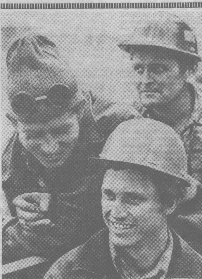
На монтаже блока 9 трудятся монтажники В. Войтюхович, В. Шевелюхин и М. Гольтаев из бригады А. Колдеркина НМУ-1 Сибметаллургомонтажа.
