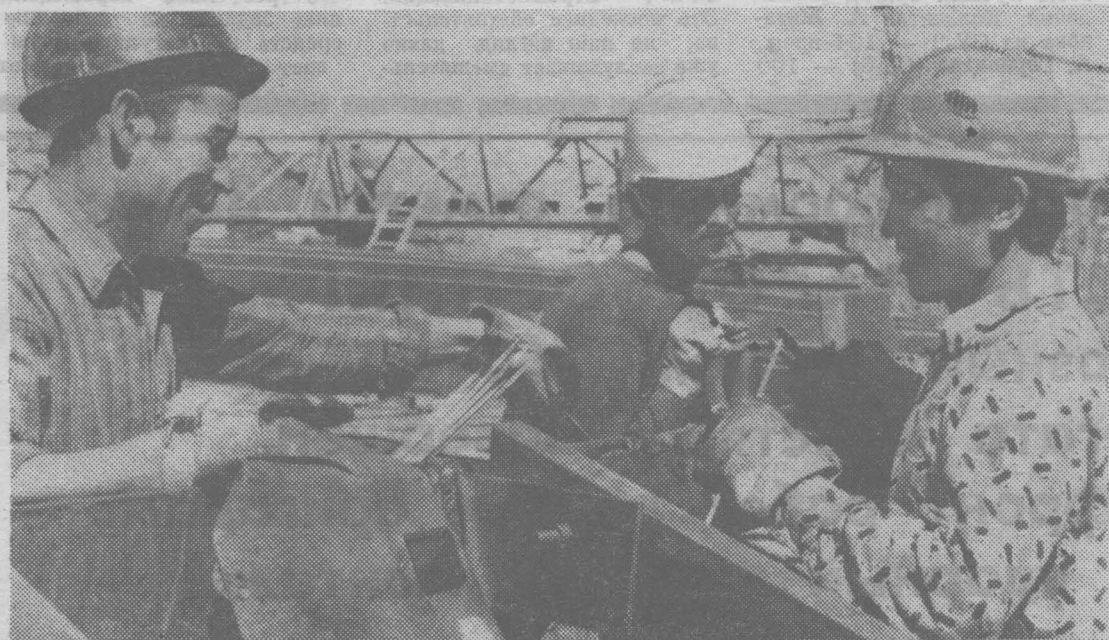
Бригада В. ВОРОНОВА на монтаже изотермической емкости.
