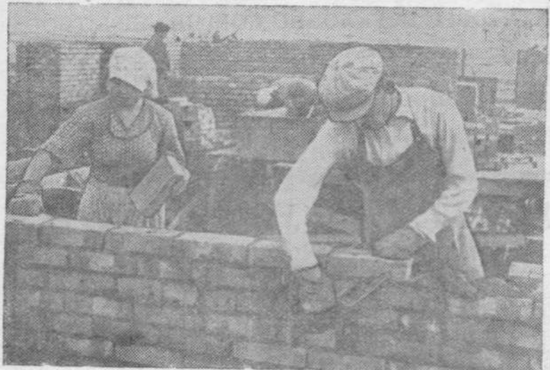
НА СНИМКЕ: Один из лучших каменщиков второго участка Юргинского строительного треста Иван Шперлинг и подсобная рабочая Анна Блюминштейн на кладке четвертого этажа нового дома на квартале 13. Фото П. Нифонтова.
