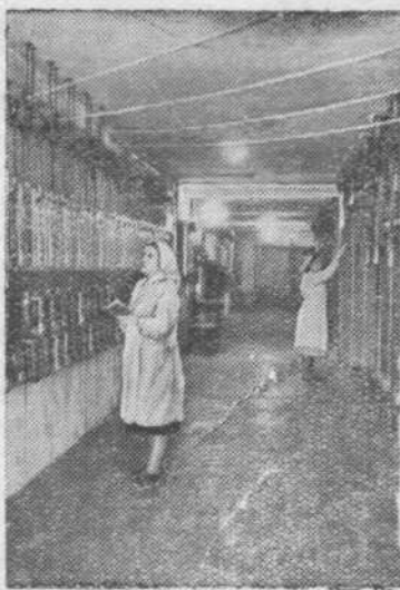
В Горьком закончено строительство первой очереди большого пивоваренного завода «Волга». Вступил в эксплуатацию механизированный солодовый цех.
