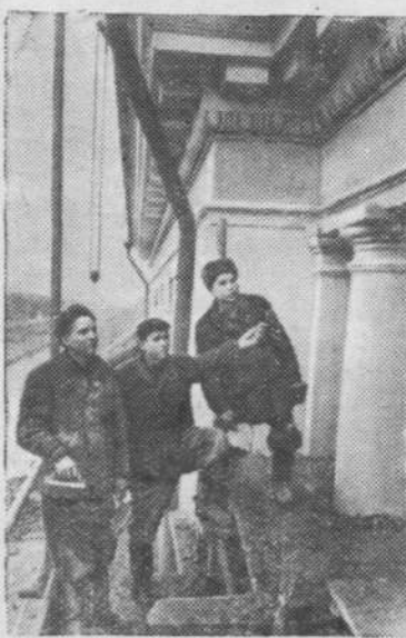
Ярославль. На стройки города пришли сотни молодых рабочих—выпускников школ ФЗО. Многие из них с первых дней работы перевыполняют сменные задания. На снимке: на строительстве жилого дома для рабочих и служащих автозавода. Знатный штукатур бригадир А. Ефимов (в центре) дает указания молодым рабочим В. Рыжову и В. Решетникову, окончившим школу ФЗО № 11.
