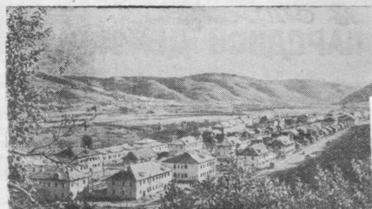
Грузинская ССР. В семи километрах от Кутаиси, на реке Рионе сооружается гидроэлектростанция — Гумати ГЭС. Неподалеку от нее вырос жилой поселок строителей.
