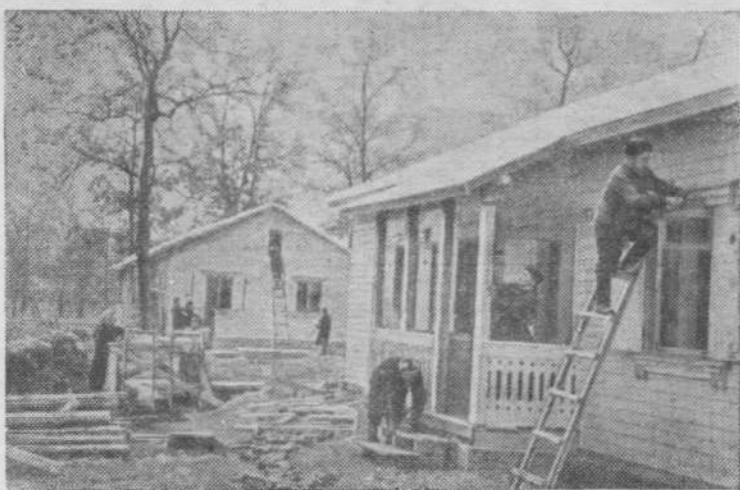
Волынская область. В Киверцовской МТС выстроены типовая мастерская, здание конторы и десять домов для механизаторов. На снимке: строительство домов в Киверцовской МТС.
