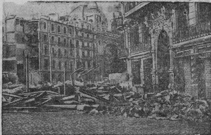
На снимке: Здание кинотеатра „Коллизей“ разрушенное бомбардировкой.
