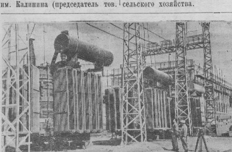
Московская область. В районе Ногинска заканчивается строительство подстанции, предназначенной для приема электроэнергии с Куйбышевской гидроэлектростанции. Первоначальное напряжение в 400.000 вольт здесь будет понижаться до 220.000 и 110.000 вольт.
