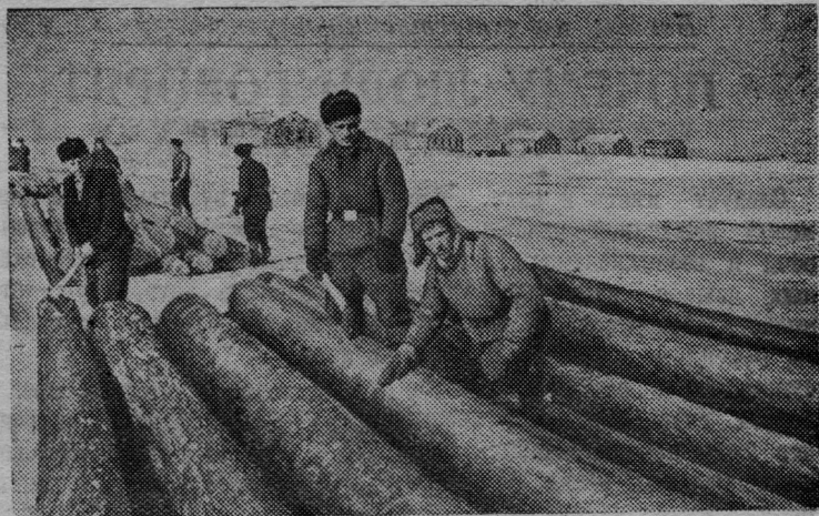
Амурская область. Большое строительство развернулось в новом совхозе «Чесноковский», созданном для освоения целинных и залежных земель. Механизаторы поселились в новых четырехквартирных домах. Успешно работает на строительстве бригада плотников во главе с бригадиром И. Кручинным.
