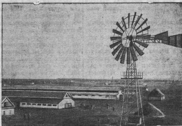
В колхозе им. Карла Маркса (Пятихатский район, Днепровской области) построен ветродвигатель, при помощи которого подается вода животноводческим фермам. Фото К. Инсарова.
