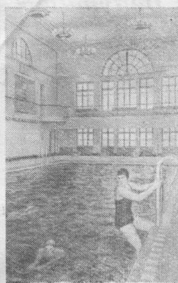
В Московском энергетическом институте имени В. М. Молотова закончено строительство зимнего плавательного бассейна. В бассейне установлена система приточно-вытяжной вентиляции, дно выложено дорожками из темной керамики для ориентировки пловца, место для поворота пловца выложено шероховатой керамикой.
