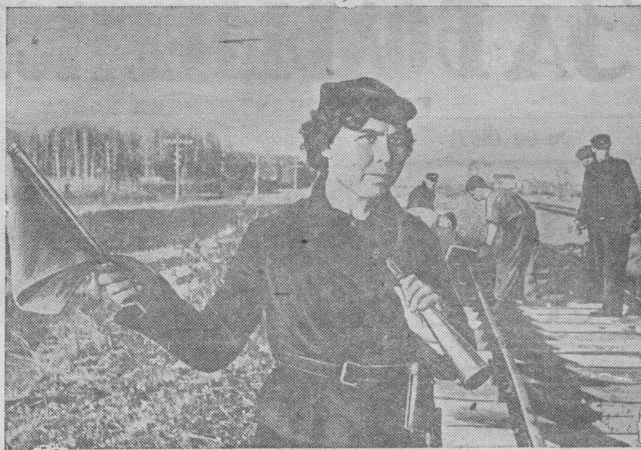
Стахановка-сигналистка ремонтной бригады МПС-19 тов. Т. Е. Фещенко. Фото В. Ларионова.
