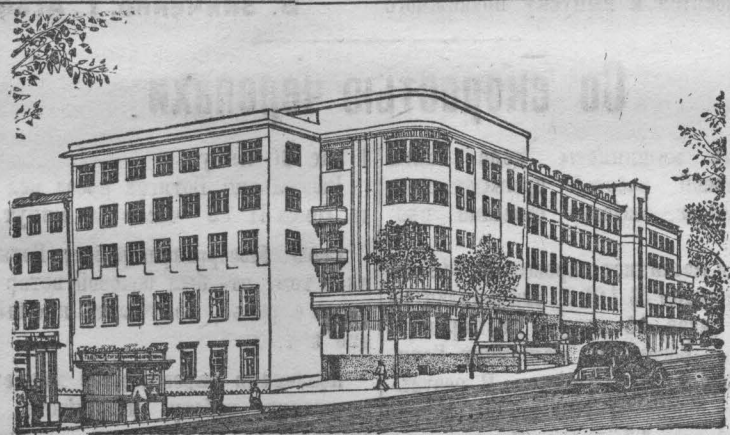
Дом правительственных учреждений Удмуртской АССР в г. Ижевске на площади им. И. Петухова. (Союзфото).
