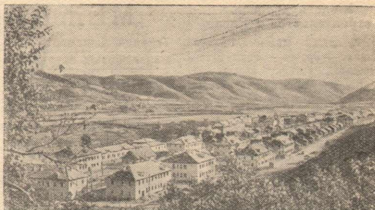
Грузинская ССР. В семи километрах от Кутанси, на реке Риони сооружается гидроэлектростанция—Гумати ГЭС. Неподалёку от неё вырос жилой посёлок строителей.
