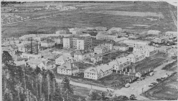
Куйбышевгидрострой. Новый соцгородок гидростроителей близ Ставрополя-на-Волге. Прессклише ТАСС.
