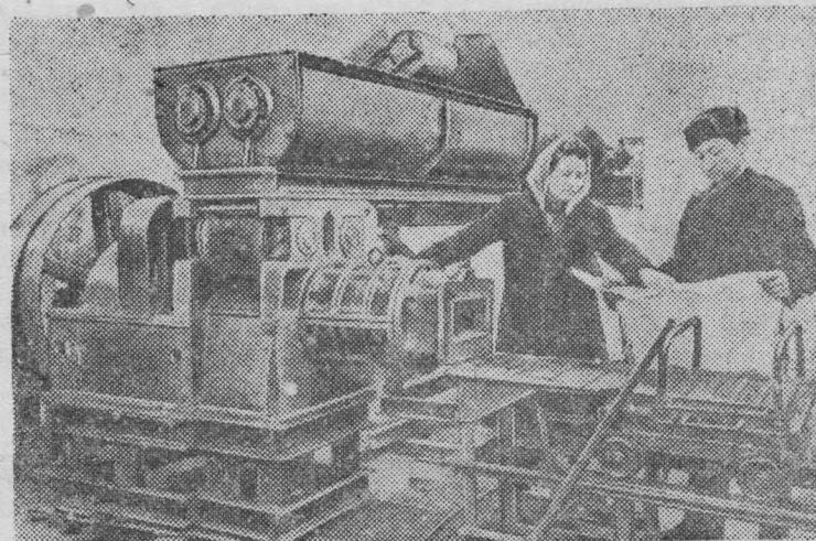
Свердловский завод «Строймашина» начал серийный выпуск кирпичноделательных агрегатов для колхозов. Это — своеобразный завод на колесах. Он состоит из вакуум-пресса, вальцов, глиномешалки и транспортера. Новую машину можно быстро перебрасывать с одного участка на другой. Производительность ее — 2 миллиона 800 тысяч кирпичей за сезон. В этом году завод выпустит 100 кирпичных передвижных заводов.
