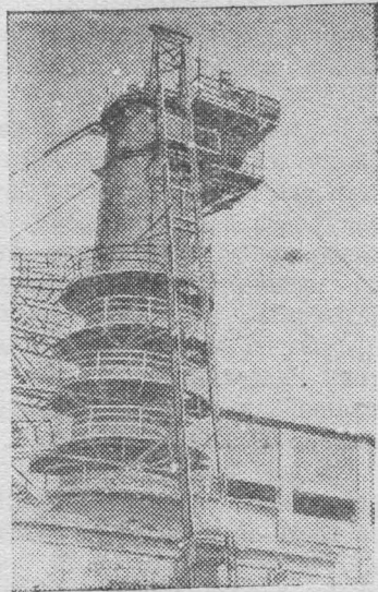
В Запорожье вступил в строй известковый завод. На снимке: восстановленная известковая печь № 1.
