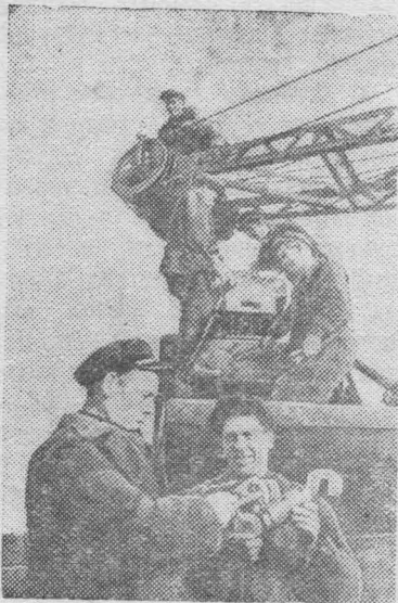
Таллин. Восстановительный поезд Эстонской ж. д. является одним из передовых. Коллектив поезда восстановил ряд подъемных кранов мощностью от 3 до 45 тонн. На снимке: монтаж восстанавливаемого крана. На переднем плане механик А. Казанцев (слева) и слесарь В. Сизов.
