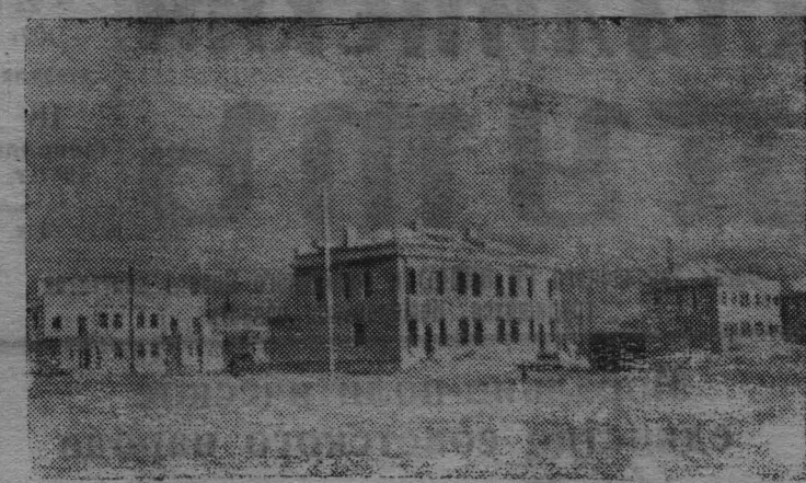
Строительство жилых домов для рабочих завода «Амурсталь» в Комсомольске-на-Амуре.
