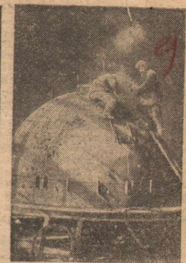
На Орском заводе металлоконструкций. Сборка газогорелков для газопровода Саратов—Москва.
