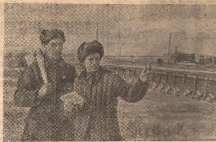
На снимке: на одном из участков строительства гидроэлектростанции на берегу Оки. На переднем плане — начальник работ инженер В. К. Коротаев (справа) и бригадир П. И. Суров.
