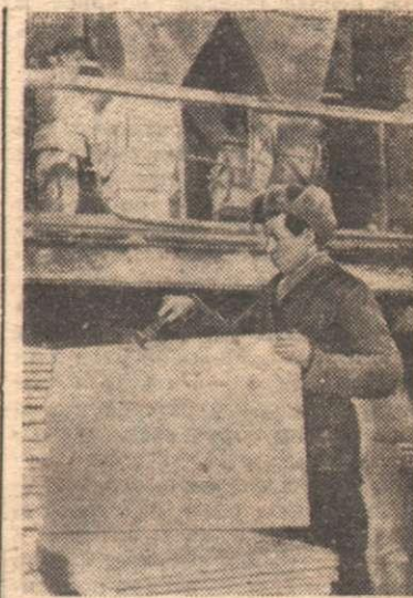
На скоростном строительстве дома (Ленинград).
