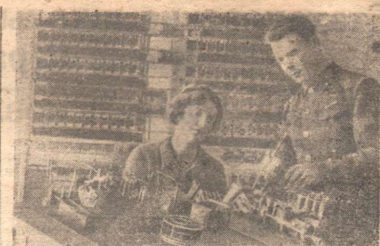
В Самарканде (Узбекская ССР) идет строительство автоматической станции, которая будет обслуживать в 1946 году до двух тысяч абонентов.
