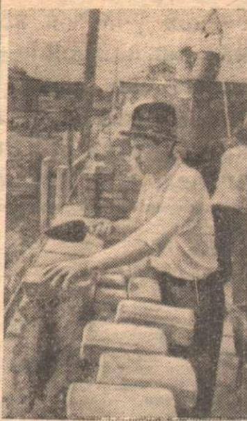
Лауреат Сталинской премии, орденоносец С. С. Максименко недавно продемонстрировал на строительстве малоэтажных домов в Щемиловке (Ленинград) разработанный им поточно-конвейерный метод кладки кирпича. За 7 рабочих часов бригада Максименко уложила 42 тысячи кирпичей, выполнив 10,5 нормы.
