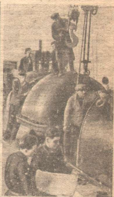
Заканчивается восстановление турбогенератора мощностью 6 тысяч киловатт на второй электростанции города Минска (Белоруссия).
