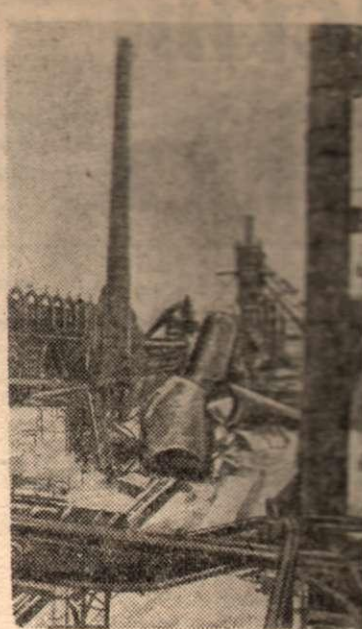
На снимке: Доменная печь № 1 металлургического завода «Криворожсталь», разрушенная немцами.
