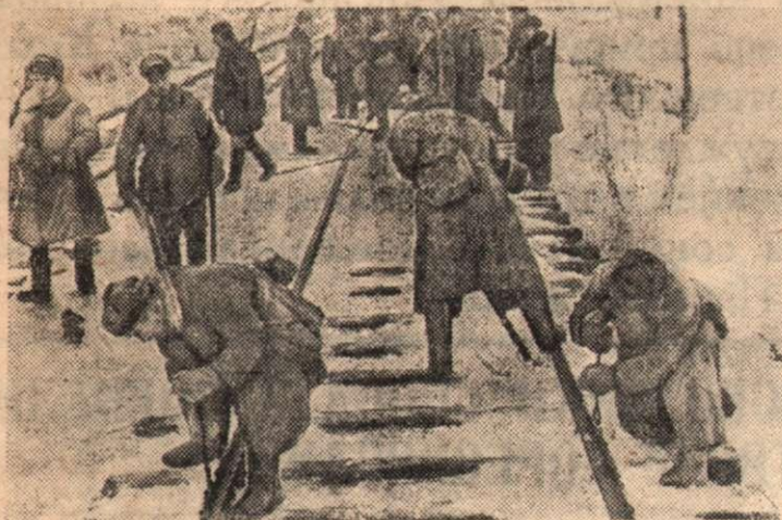
Ленинградский фронт. На освобожденной от немецких захватчиков земле. На снимке: восстановление железнодорожного пути на одном из участков.
