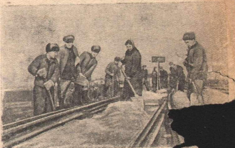
Восстановление железнодорожных путей. На снимке: Укладка стрелочных переводов на Н-ской станции.
