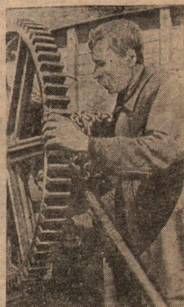
Слесарь 3-го вагонного участка Юго-Западной ж. д. П.А. Базаз устанавливает подъемный кран, поврежденный немцами при отступлении.
