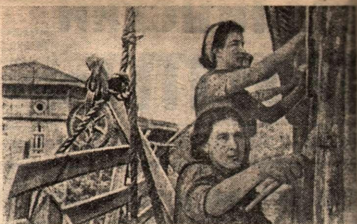
Трудающиеся Одессы залечивают раны, нанесенные немецкими бандитами. Восстанавливаются заводы, жилые здания, приводятся в порядок улицы, парки. На снимке: стахановки-водницы К. И. Ковалева и Е. А. Никитова ремонтируют дом водников.
