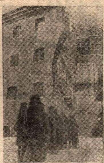
В освобожденном Сталинограде. Один из домов разрушенных немцами.
