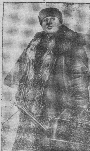
Передовой поездной вагонный мастер Омского резерва лунинец А. Сивоконь. Ремонт ударных и ходовых частей вагона он производит своими силами без задержки поезда.
