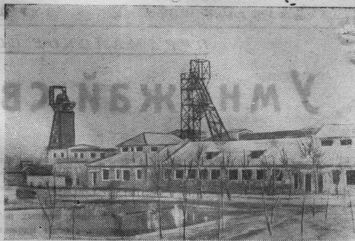
Ворошиловградская область. В тресте «Калинуголь» полностью сдана в эксплуатацию крупная шахта 4-2 «Ирмино». На снимке: общий вид шахты.
