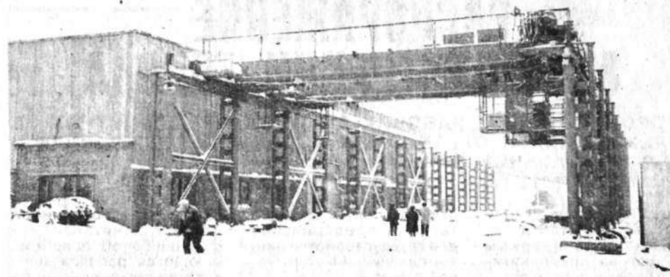
Здание ремонтной мастерской.
