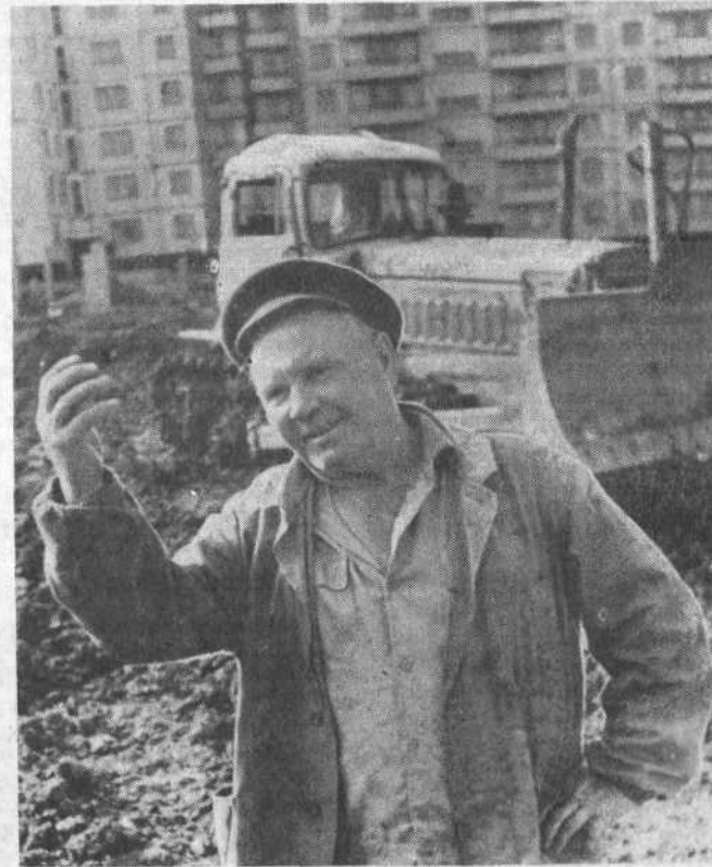
МАШИНИСТ бульдозера Федор Егорович Гилев трудится в экипаже своеобразщиков в управлении строительной механизации домостроительного комбината со дня основания предприятия. Начинать забивать сваи под новые
