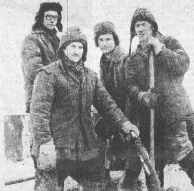
БРИГАДА плотников-бетонщиков А. Н. Чебрукова из 2-го шахтостроительного управления треста «Про-
