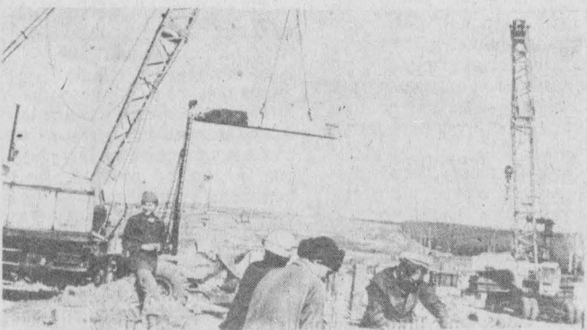
Вторая очередь завода КИДС. Заканчивается забивка свай.
