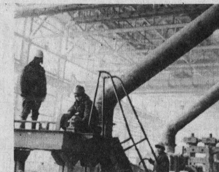
● На Московском металлургическом заводе «Серп и Молот» (Калининский район) строится цех холодной прокатки нержавеющей ленты. В новом современном корпусе на площади 50 тысяч квадратных метров в настоящее время полным ходом идет монтаж современных поточных линий, автоматизированных и механизированных агрегатов и другого оборудования.
