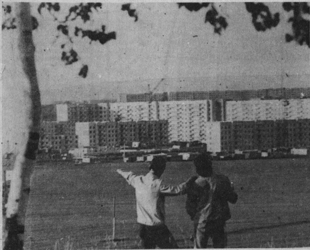
Строительство новых домов в третьем микрорайоне.
