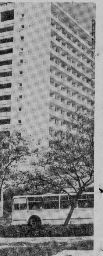
В Севастополе заканчивается сооружение многоэтажной гостиницы «Крым» на 640 мест. Строительство гостиницы (на снимке) ведет СУ-42 треста «Севастопольстрой».
