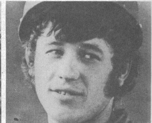
Стройка уверенно выходит на финиш. На снимках: бригадир Н. СЕМЕНОВ (справа) и монтажник А. ФЕДОСЕЕВ; реакторные мешалки; один из передовых монтажников бригады Н. Семенова А. АБРОСИМОВ.
