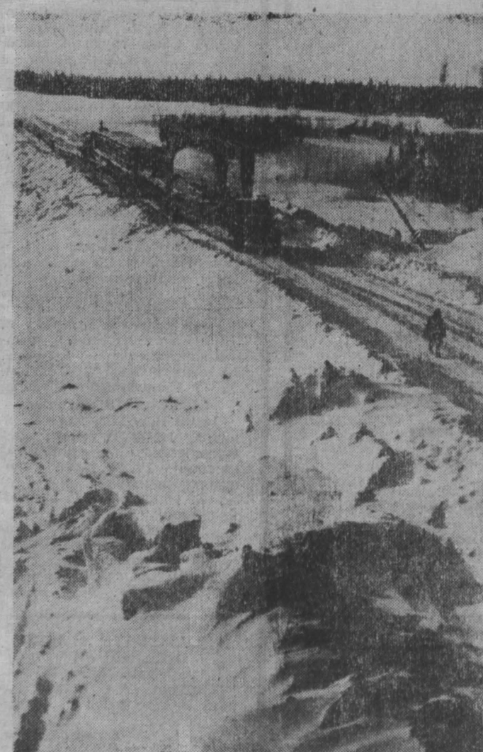
НА СНИМКЕ: таешная трасса. Идет укладка рельсов.
