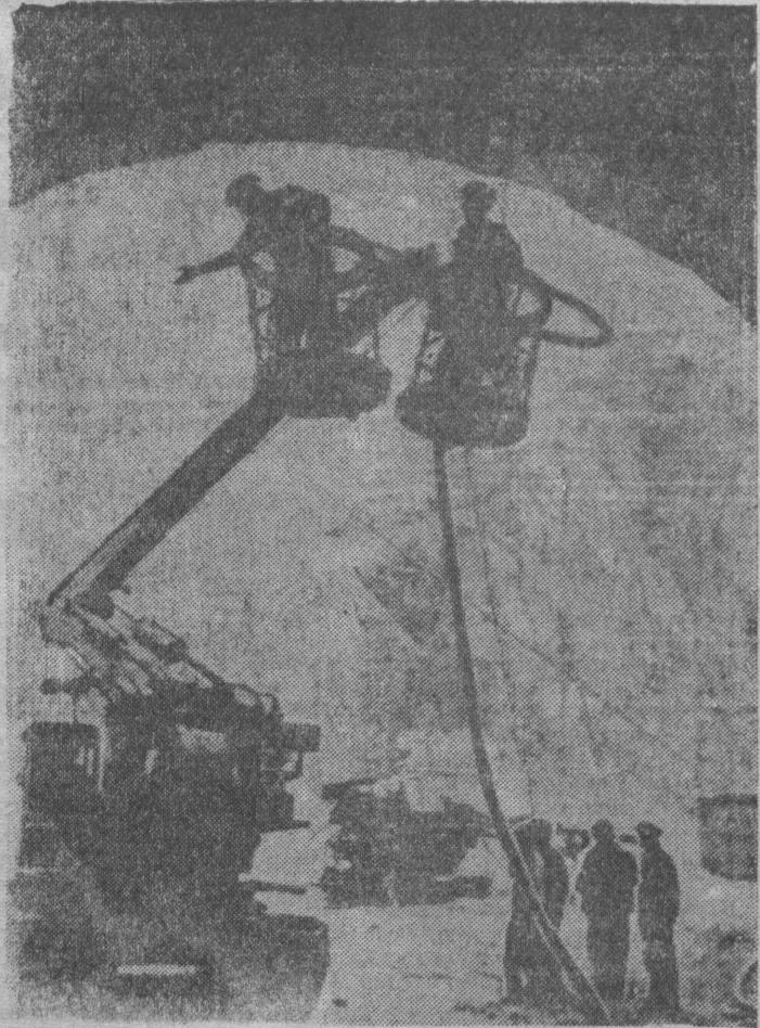
КИРГИЗСКАЯ ССР. На строительстве Токтогульской ГЭС скалолазы-высотники, монтажники, взрывники ведут обработку скальных склонов, чтобы обеспечить безопасность работы в котловане, где сейчас идет укладка бетона в тело плотины. Заканчивается выемка грунта из котлована под здание ГЭС.
