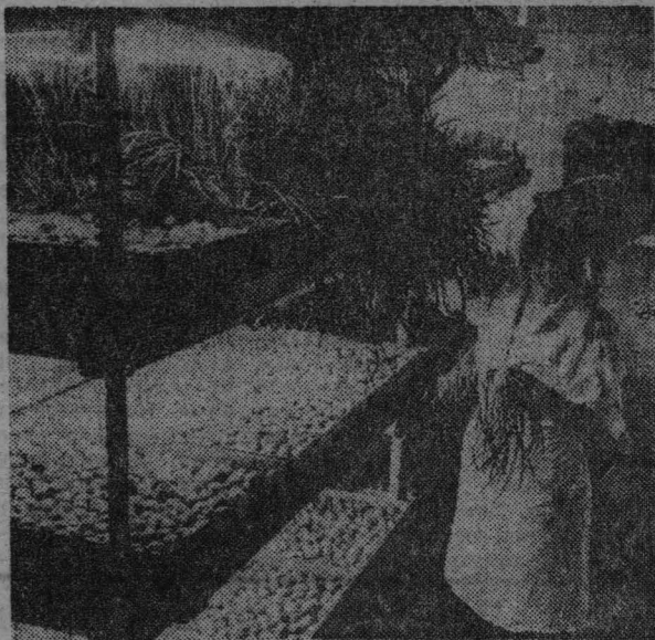
● ЛЕНИНГРАД. В Специальном конструкторском бюро сельхозмашин создана стационарная установка для выращивания зеленого лука методом гидропоники, предназначенная для ресторанов, кафе, столовых.
